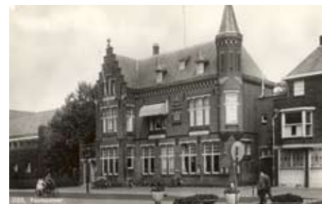
Het postkantoor uit 1904 aan de Molenstraat werd in 1972 gesloopt (coll. Stadsarchief Oss).
