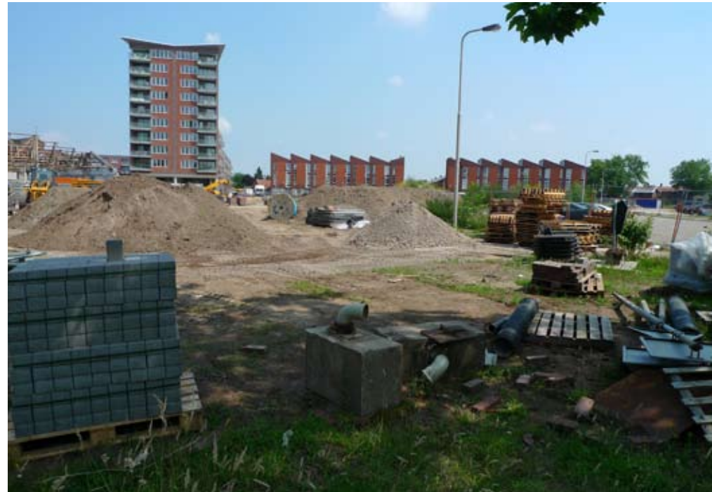
Nieuwbouw op het voormalige Bergoss-terrein.
